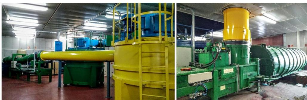
Ilustración 4. Planta de recogida neumática: Izda. Conducciones y ciclones. Dcha. Contenedores compactadores.
