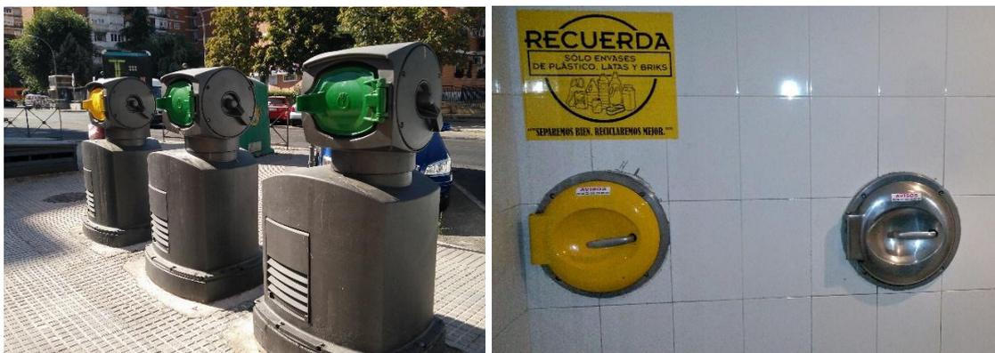
Ilustración 3. Recogida neumática: Izda. ZA, buzones callejeros. Dcha. LN, buzones domiciliarios.
